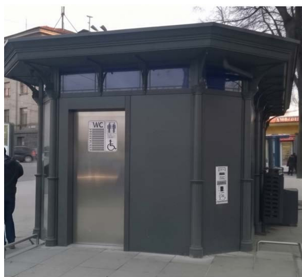
Gabinetto autopulente per zona storica
