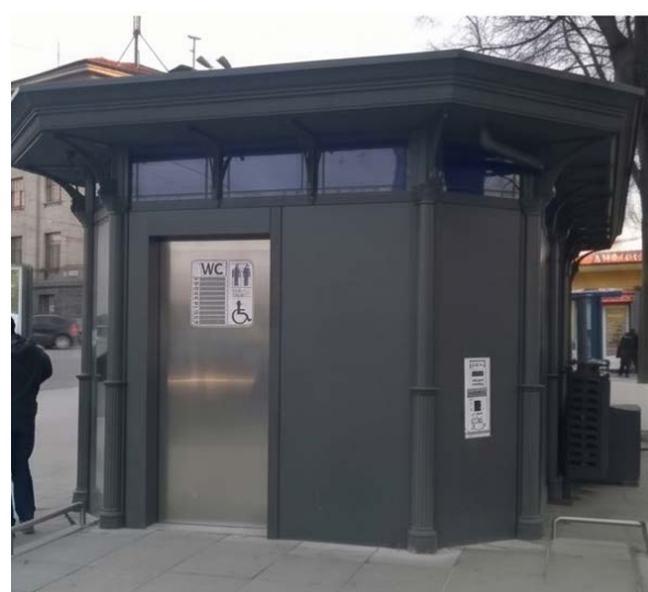
Gabinetto autopulente per zona storica
