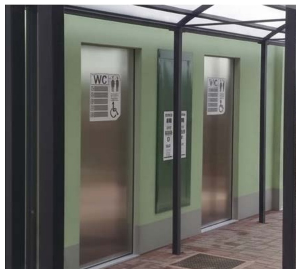
Doppio wc autopulente con tettuccio antipioggia
