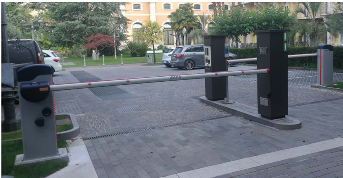
Sbarre (barriere) automatiche alimentate a energia elettrica di 5 m per accesso / di 5 m per uscita
