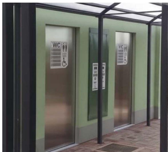
Doppio wc autopulente con tettuccio antipioggia
