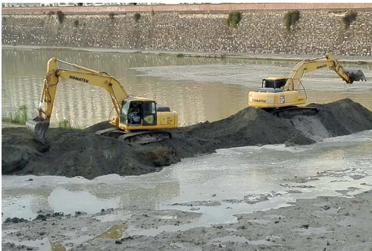
Firenze, fiume Arno di fronte a piazza Piave, movimento terra che aumenta l'altezza del letto del fiume
