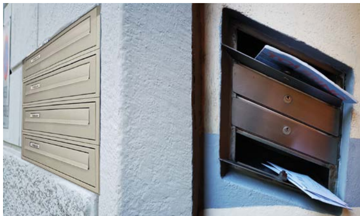
Cassetta postale a filo muro con apertura dal corridoio interno
