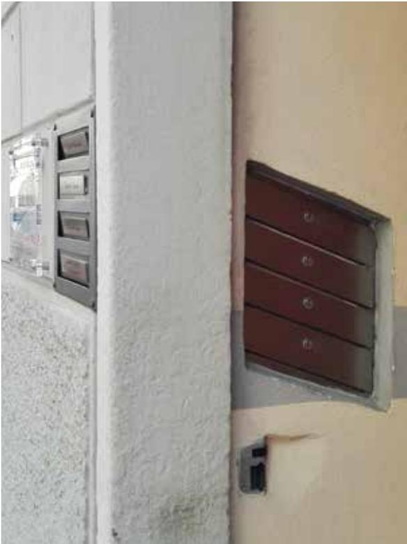
Particolare vista d'angolo del box d'acciaio inox con cassette poste in orizzontale
