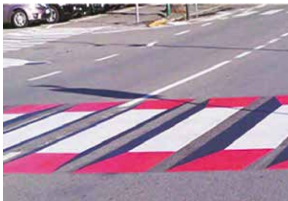
Strisce pedonali realizzate su fondo stradale con colorazione non conforme a legge
