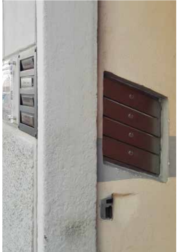
Particolare vista d'angolo del box d'acciaio inox con cassette poste in orizzontale
