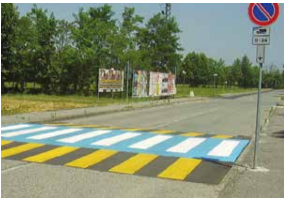
Attraversamento pedonale rialzato non conforme a legge
